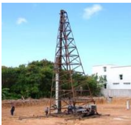
รูปภาพการตอกเสาเข็มโดยปั้นจั่นโครง
