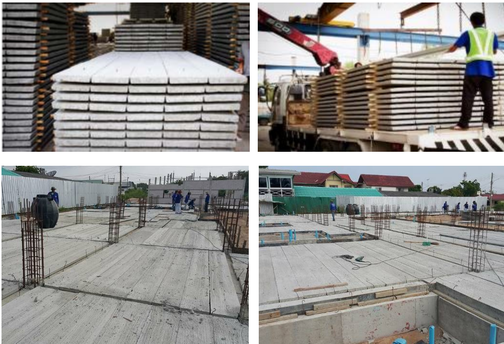
รูปภาพแผ่นพื้นคอนกรีต
