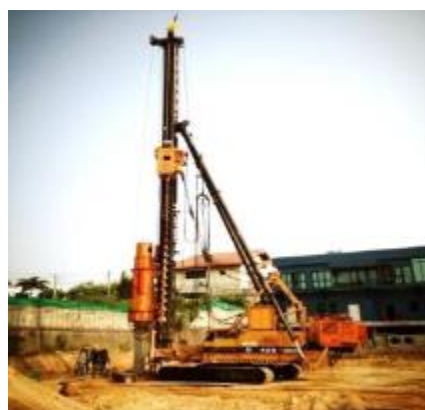
รูปภาพการตอกเสาเข็มโดยปั้นจั่นชนิดไฮดรอลิกแฮมเมอร์
