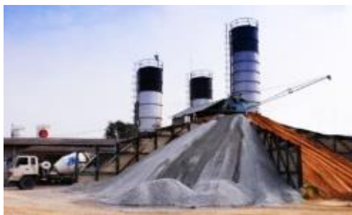
รูปภาพวัตถุดิบและเครื่องผสมคอนกรีตผสมเสร็จ
